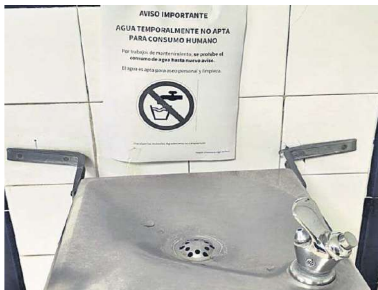
Imagen de uno de los carteles en hospital que advertía de que el agua no era apta para el consumo.
